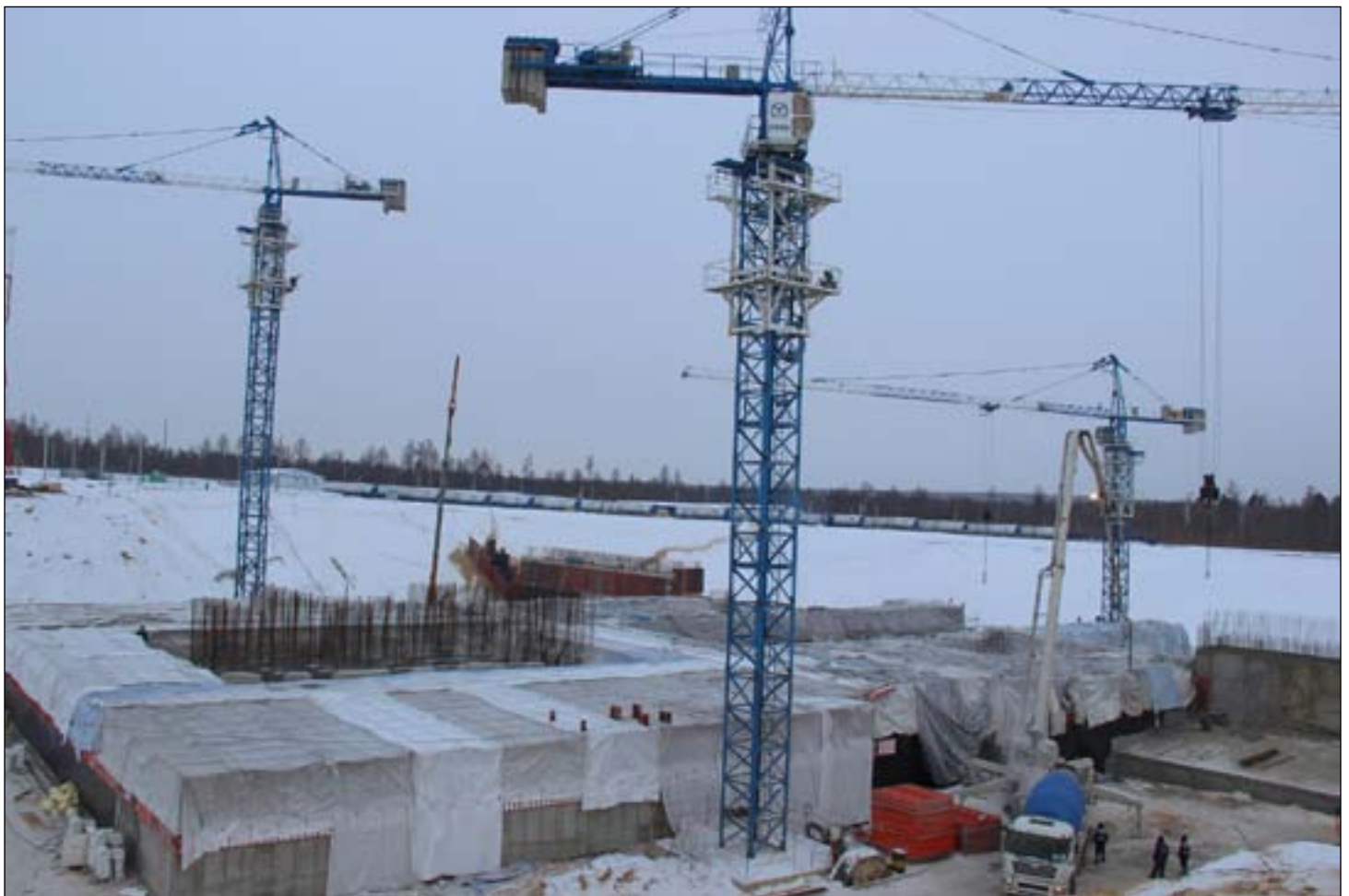
Строительство технического комплекса космодрома «Восточный»
