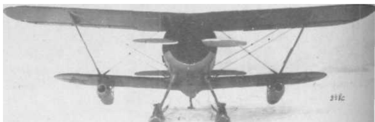
Истребитель И-15-бис (И-152) с ПВРД (1940 г.)
