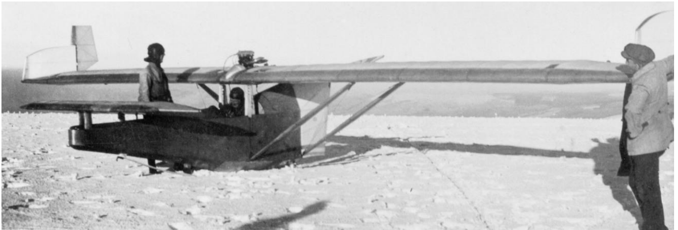
Im Winter 1927/28 wurde die RRG „Ente“ mit einem 9 PS DKW-Motor ausgerüstet. Links am Flugzeugrumpf stehend mit Fliegermütze ist Alexander Lippisch auszumachen. Das Bild zeigt sehr gut die geänderte Seitensteuerung auf den Flügelspitzen mit starren Flossen und beweglichen Ruderflächen. (Sammlung DEHLA)
