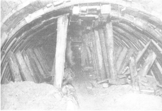
Abb. 4. Kalotten-Zimmerung des neuen Semmeringtunnels. (Aufn. Dipl.-Ing. Rudolf Zimmer- mann)
