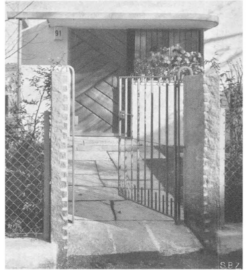
Abb. 4. Haustür. — Photos Steiner-Heiniger.
