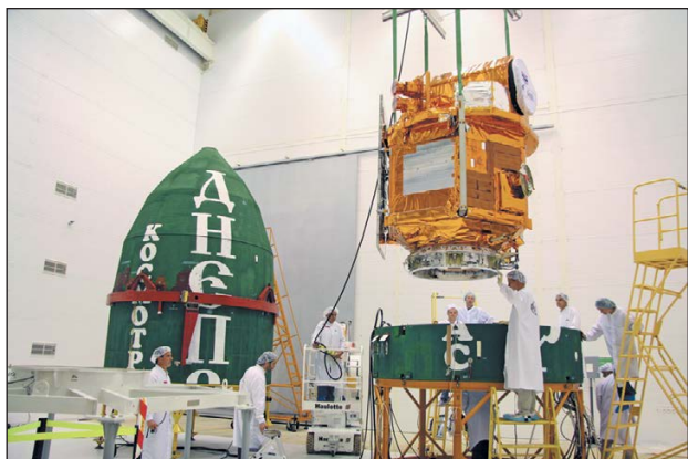
Установка спутника в космическую головную часть РН «Днепр»
