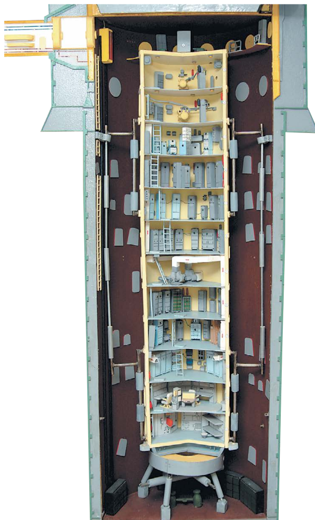
Макет подземного командного пункта запуска ракет. Боевой расчет находился на нижних этажах: 11-й – зал управления, 12-й – комната отдыха
