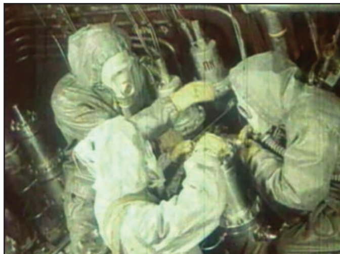
Проверка герметичности фланцевых соединений системы централизованной заправки
