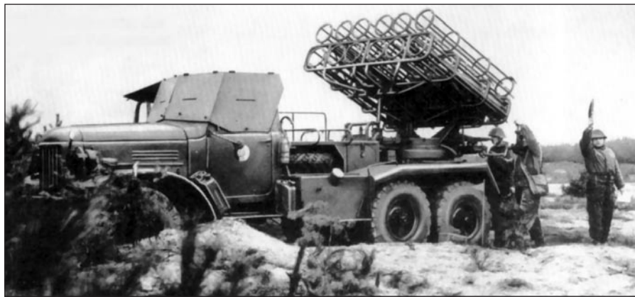
БМ-24 (8У31) готовится к стрельбе. На направляющих установлены турбореактивные снаряды М-24 (турбореактивные снаряды были короче оперенных, и для них не требовалось длинных направляющих). Кабина машины прикрыта защитными щитами
