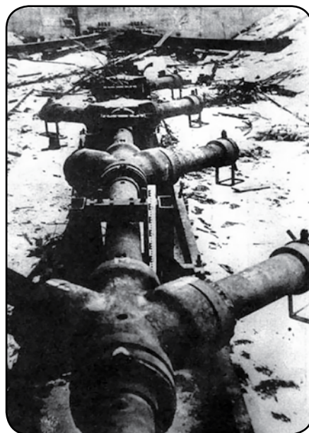
Остатки ствола сверхдальнобойной пушки Hochdruckpumpe («V-3») на площадке у берега Па-де-Кале
