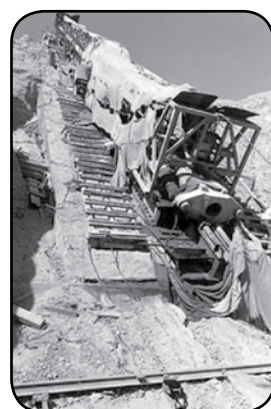
Многокамерное орудие «Малый Вавилон», со стволом диаметром 350 мм, построенное под руководством Бюлля в Ираке. Таким его обнаружили эксперты ООН
