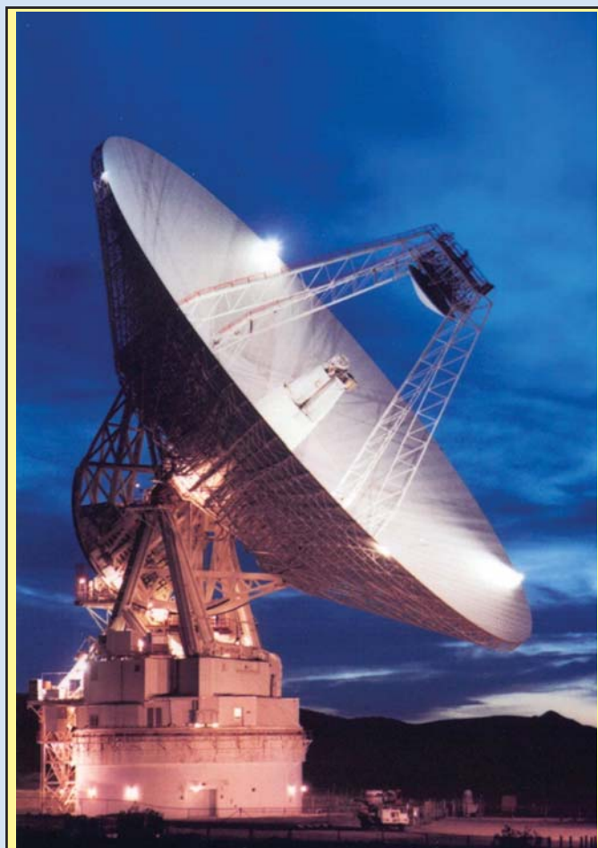
Рис. 9. 70-метровая антенна в Калифорнии Goldstone, способная обнаружить частицы мусора размером в 2 мм на расстоянии 1000 км
