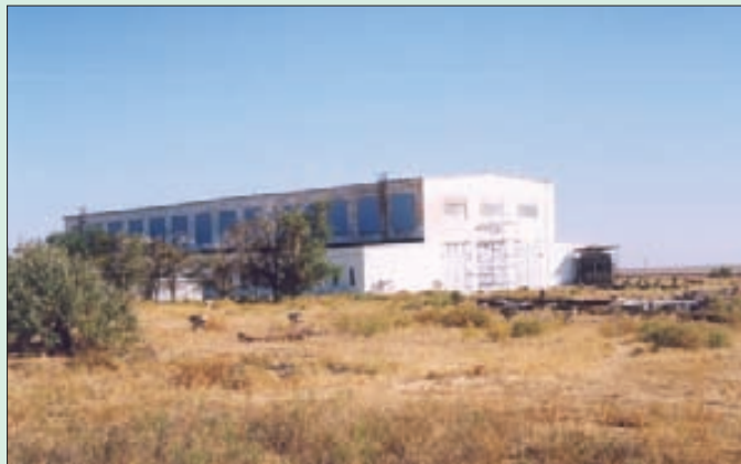
Монтажно-испытательный комплекс РН «Циклон-2»
