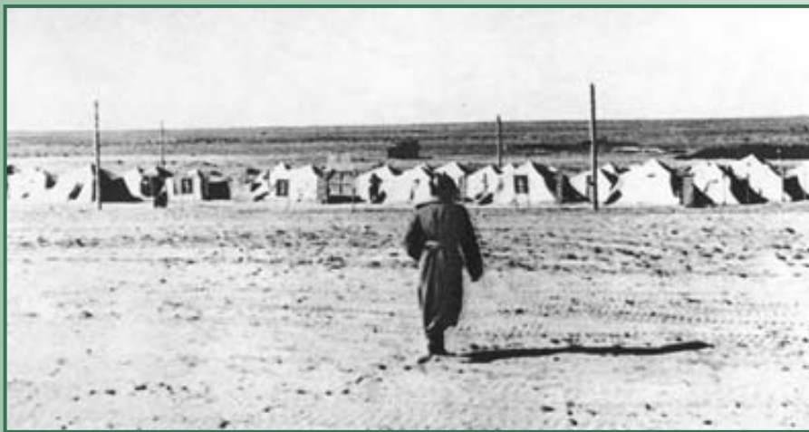
Палаточный городок строителей космодрома
