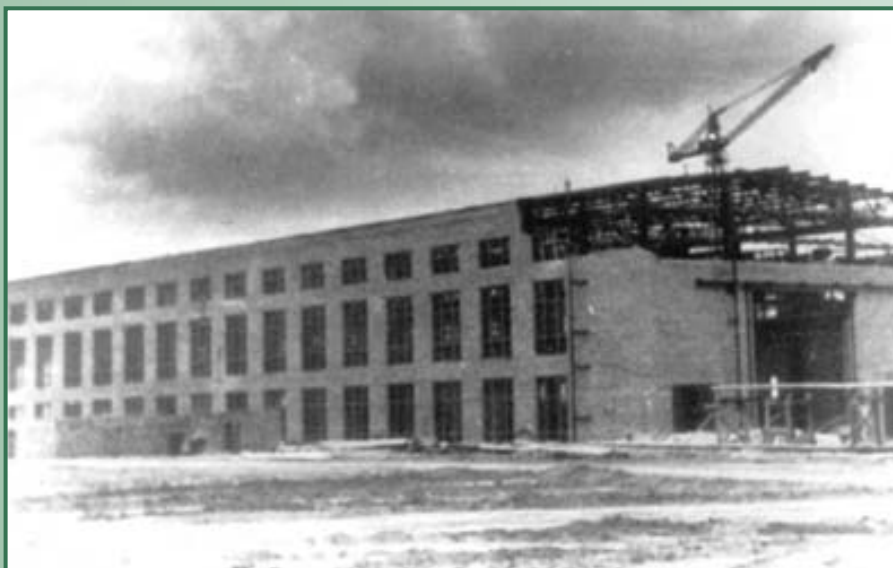
Строительство МИКа на 2-й площадке
