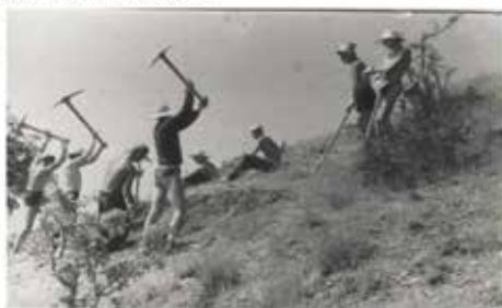
Подготовка площадок для дорожек и палаток
